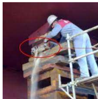
図 11 作業員による砂箱の操作
