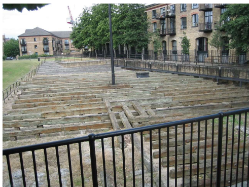
図 50 グレート・イースタン号の スリップウェイ 傾斜造船台の遺跡(Wikimedia より)
