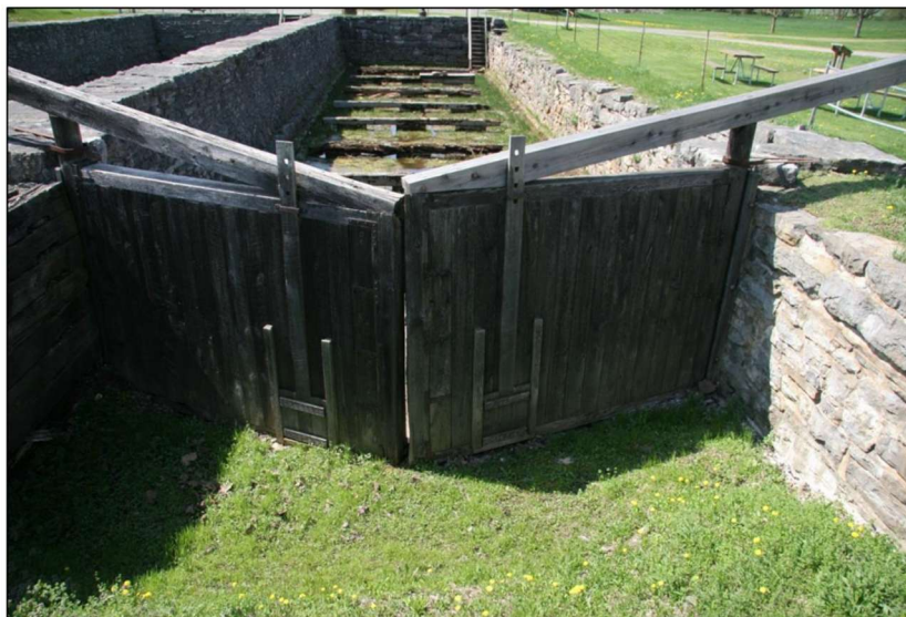
図 52：フラップ型とマイター型の扉の説明板：フラップ型の扉の開閉は一人の作業員がハンドル・クランクを巻いて行う。向かって右にマイター型の扉を持つ船渠が見える。こちらは、船渠の両側の上に二人が居て、左右の扉を同時に開閉する。
